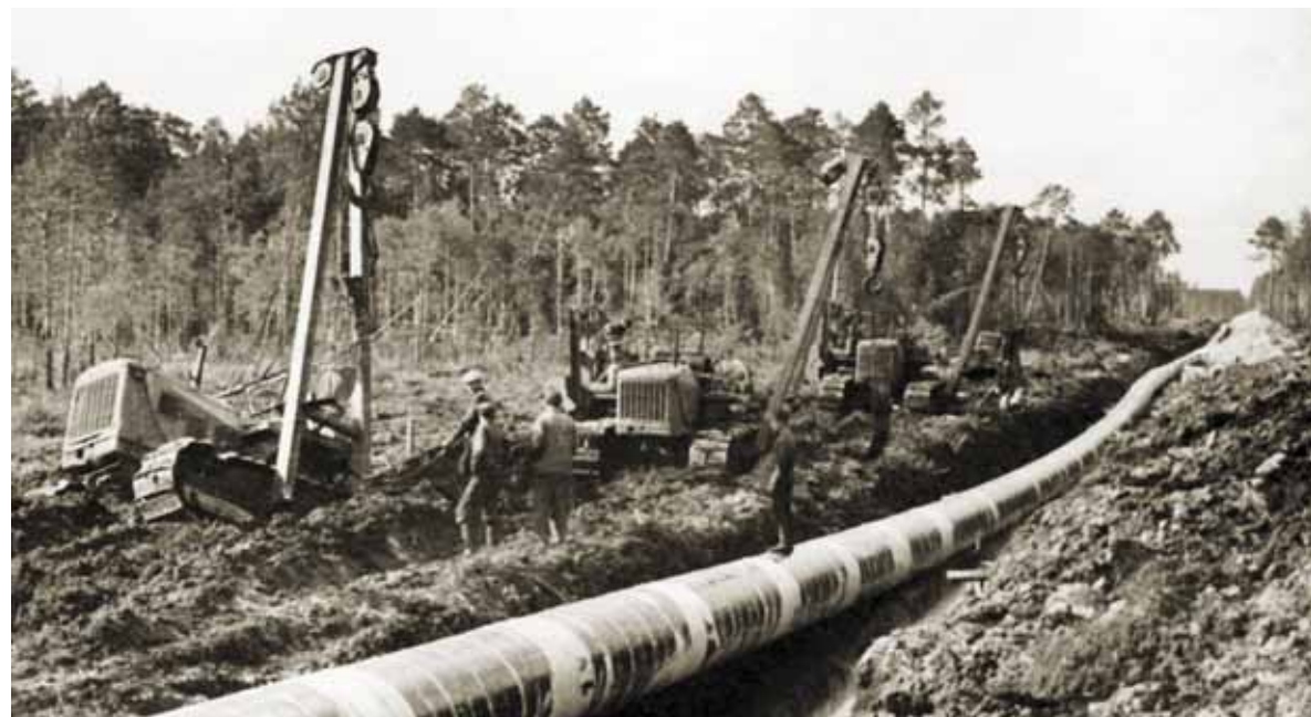
Строительство нефтепровода Шаим — Тюмень (1962—1963 гг.)
